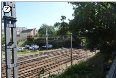
155 Infrastructures de la gare de Poitiers (photo hors aire d'étude éloignée)
