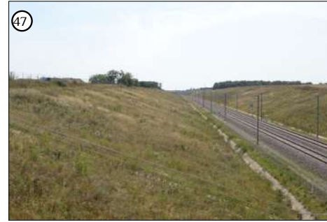
Le tracé de la voie LGV en déblai par rapport au plateau qu'elle traverse
