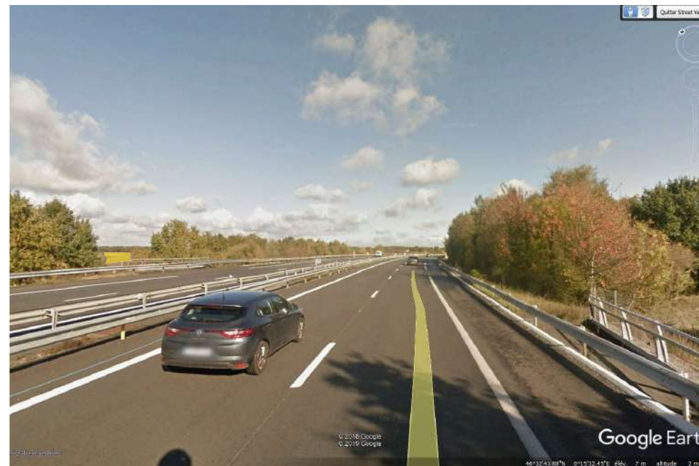
Vue 4 : Au niveau du pont franchissant la départementale D87. La vision se ferme largement en direction de la zone nord
