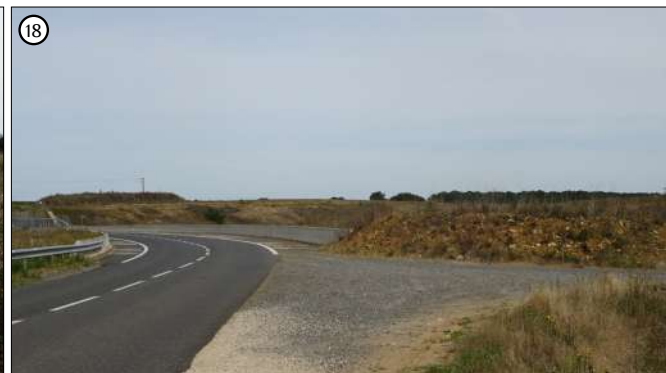
18 Au niveau de la zone de contact avec la départementale D87, le chemin s'élargit et le talus qui accompagnait le chemin devient un merlon de terre imposant
