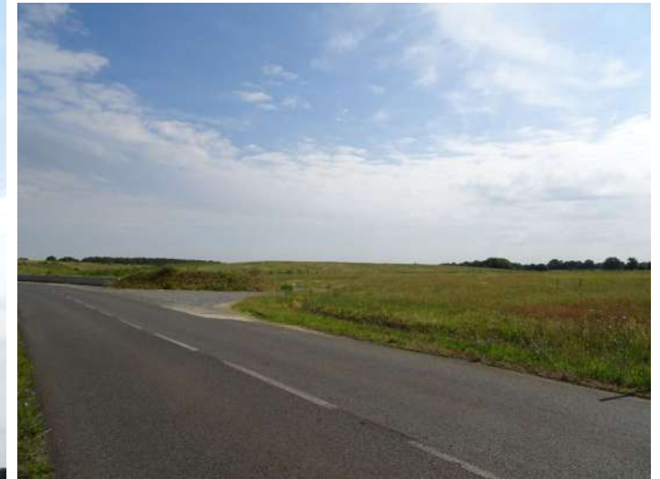
VUE DEPUIS LA D87 AU NIVEAU DE L'AIRE D'ACCUEIL : VUE PC6-01 (ÉQUIVALENT VUE 18 DE L'ANALYSE PAYSAGÈRE) _ ETAT EXISTANT
