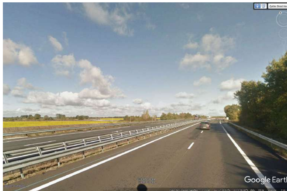
Vue 2 : Un peu après l'antenne relais. La vision est très proche de celle du point 1. La voie est légèrement décalée par rapport à l'orientation plein Sud des panneaux
