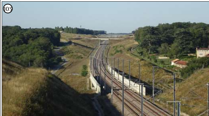
103 Profonde modification de la topographie pour assurer le passage de la ligne LGV conçu en déblai. La lecture de la vallée de la Boivre, coupée ici par la voie, est gommée par les aménagements lourds
