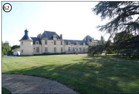
Le château les Piliers (commune de Fontaine-le-Comte)
