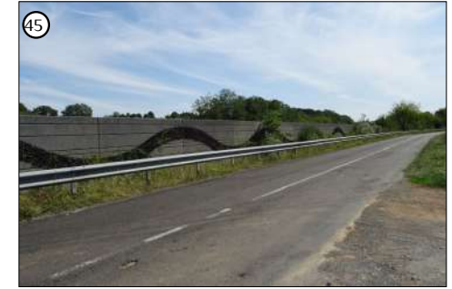
Les murs anti-bruit : un vocabulaire autoroutier pour protéger le vaste lotissement au lieu dit de la Grande Vallée (commune de Vouneuil-sous-Biard)
