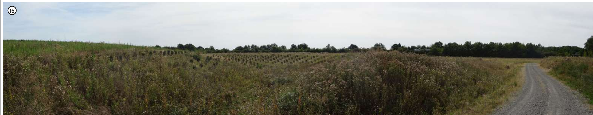
Panorama depuis le chemin de ceinture au niveau des aménagements assurant la gestion des eaux de pluie et de ruissellement
