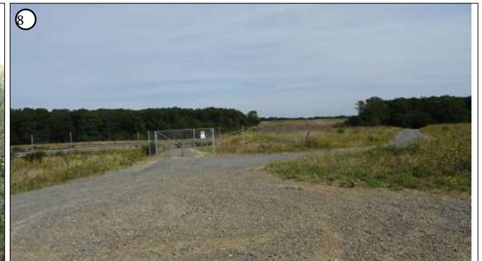
8 Le chemin s'élargit ici en une plateforme. On note le départ d'un chemin en direction du bassin de retenue artificiel et les clôtures de protection de l'espace de la voie ferrée qui doit rester inaccessible
