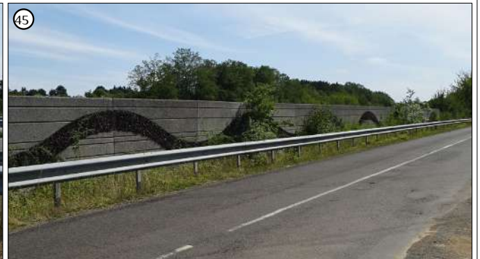
45 Ici, les glissières sont associées à un mur anti-bruit en raison de la proximité d'un lotissement
