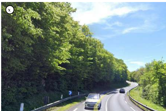
Site 2 site de la grotte Saint Jean : La grotte est localisée le long de la départementale D4 non loin de l'intersection avec la voie ferrée. La densité des boisements de la vallée de la Menuse masque totalement les versants et l'entrée de la grotte. Seul un panneau d'information donne une indication sur l'existence de cette grotte
