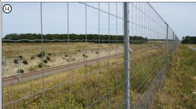
14 En haut du talus, on aperçoit la voie ferrée en contrebas
