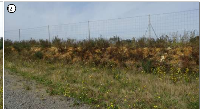
12 Le talus surmonté d'une haute clôture qui accompagne le chemin à l'Ouest, toujours pour empêcher l'accès à l'espace de la voie ferrée
